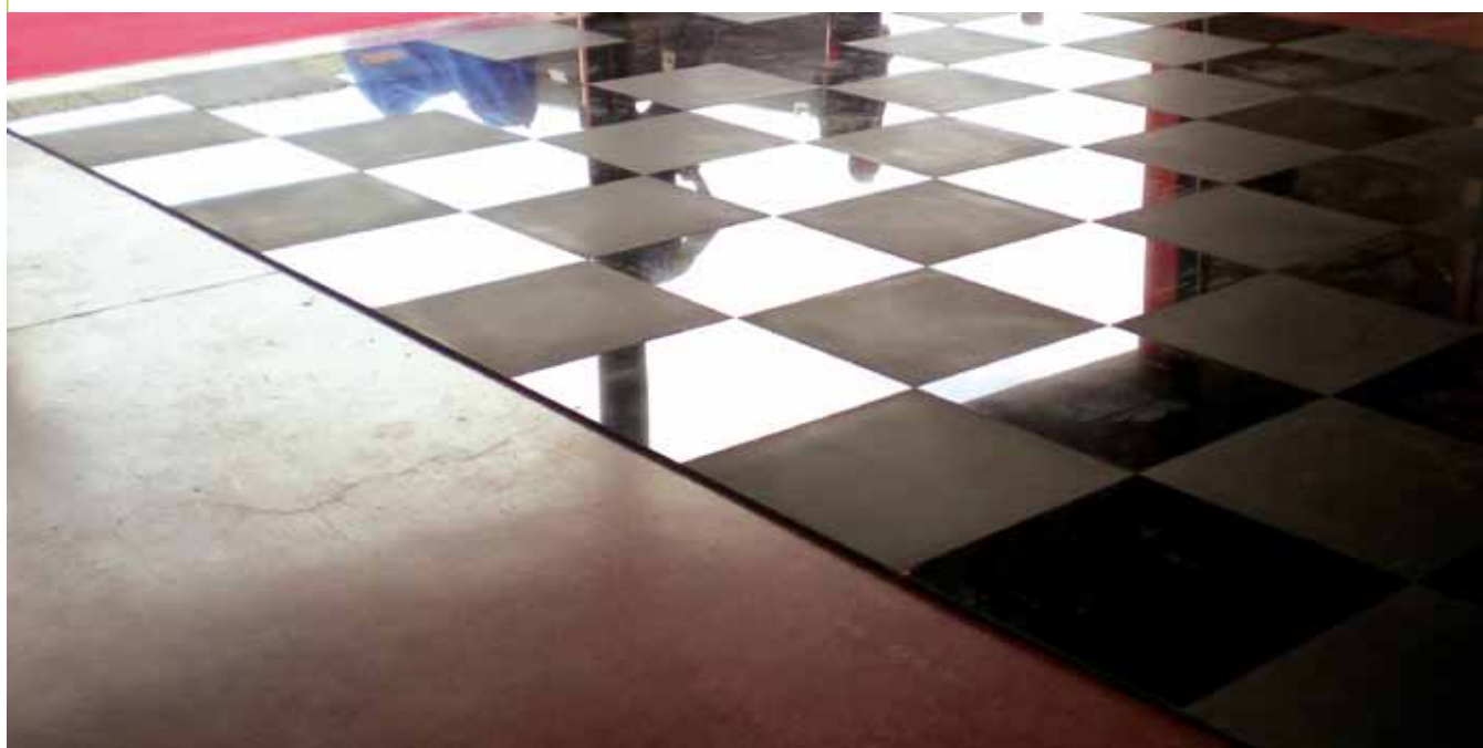
Easyfloor su pavimento esistente
